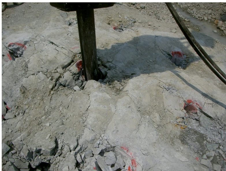
芯抜きセリ矢破碎完了
