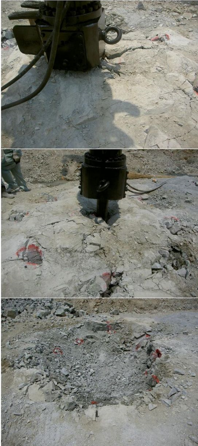
割岩後の状況写真
